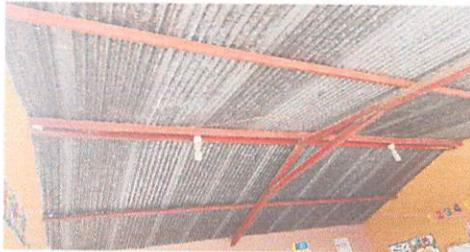
Sustitución de lámina, por lamina troquelada de aluzinc callbre 26. Desinstalación de lámina Existente.
