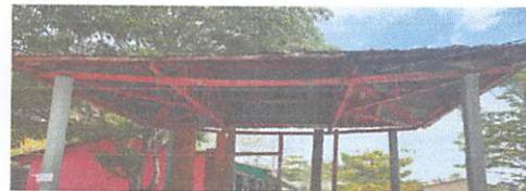
Sustitución de estructura de soporte de madera por metal.
