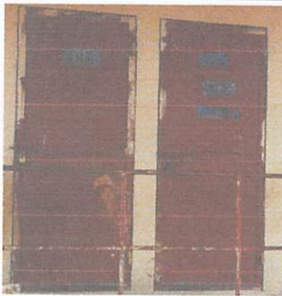
Mantenimiento a estructura (lijado, cambio de tubo , cepillado, sujeciones, aplicación de pintura)
