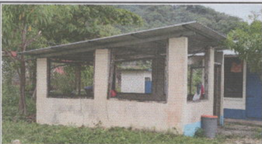
Foto 3: De esta manera quedó evidenciada mediante esta fotografía la instalación de la lámina troquelada aluzinc calibre 26 en la cocina.
