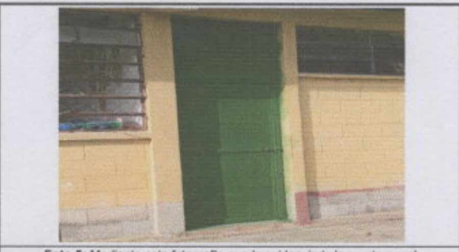
Foto 5: Mediante esta fotografía queda evidenciada la puerta por el mantenimiento de lijado, cepillado, cambio de lámina y aplicación de pintura que se realizó en la puerta.
