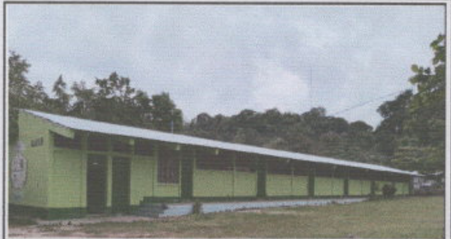
Foto 2: En esta fotografía se puede observar como quedó instalada la lámina troquelada aluzinc calibre 26, en su totalidad en las aulas.
