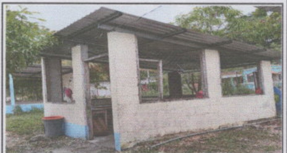
Foto 4: Por medio de esta fotografía de perfil queda evidenciada la instalación de la lámina troquelada aluzinc calibre 26 en la respectiva cocina.
