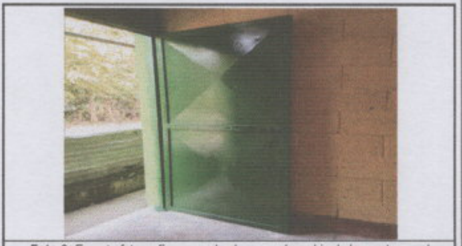
Foto 6: En esta fotografía se puede observar el cambio de la puerta por el mantenimiento de lijado, cepillado, lámina dañada y aplicación de la pintura que se hizo en la puerta, en la parte de atrás de la dirección.
