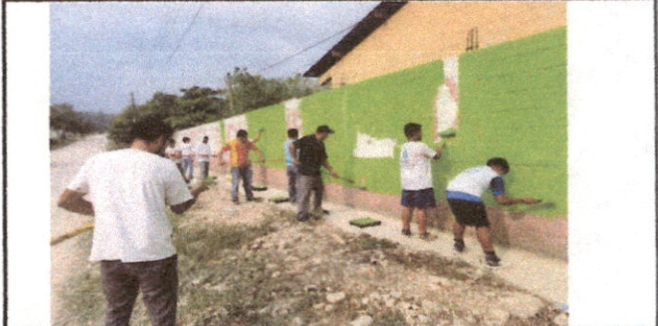
Foto 8: Aplicación de pintura en muro frontal de la Escuela.
