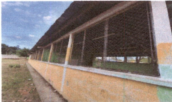
Foto 3: Renglon 5.6. Sustitución de balcones de metal en la parte de atrás de las aulas del modulo 1
