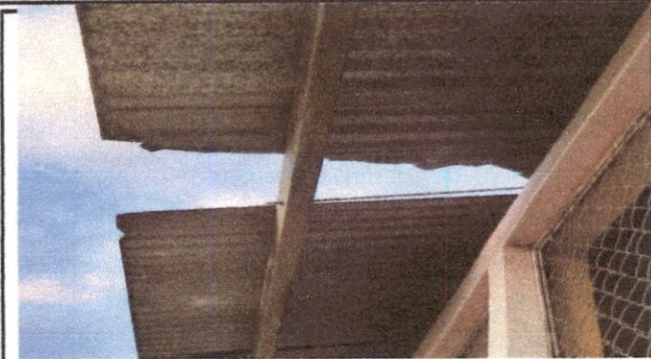
Foto 1: Renglon 1.1 Sustitución de lamina, por lamina troquelada aluzinc calibre 26 en el Modulo 1 de la Escuela
