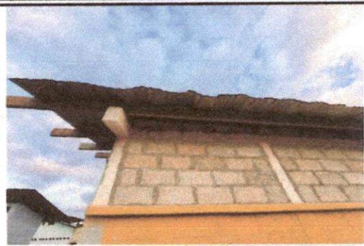
Foto 2: Renglon 2.2. Mantenimiento a estructura de soporte de metal en modulo 1 de la Escuela
