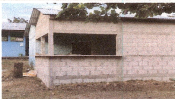
Foto 5: Renglon 21.2 Cernido en muro exterior e interior de la Cocina Escolar, Renglon 19.1 Fabricación e instalación de ventanas en cocina. Renglon 9. Pintura en exterior e interior de cocina
