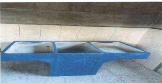
Foto 11: Sustitucion de pila de dos lavaderos
