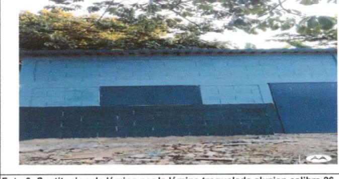
Foto 6: Sustitucion de lámina por la lámina troquelada aluzincn calibre 26
