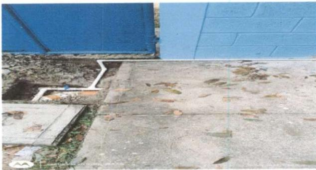
Foto 9: Reparacion de tuveria PVC linea principal lineales
