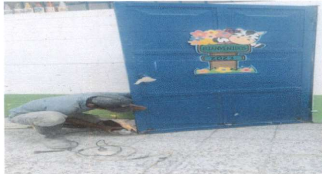
Foto 8: Mantenimiento a estructuras
