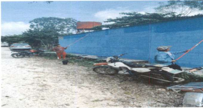
Foto 1: Pintura de muros interiores y exteriores
