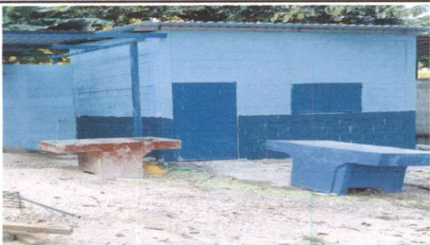
Foto 11: Sustitucion de pila de dos lavaderos
