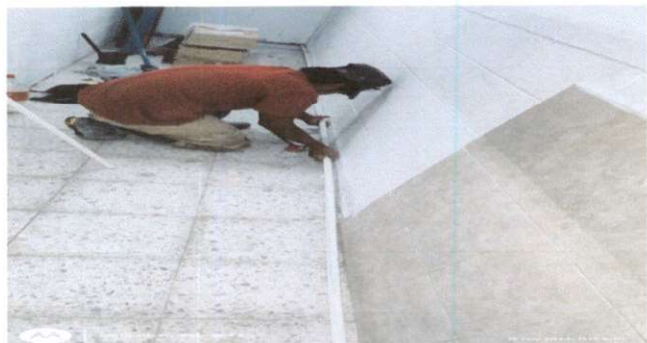
Foto 9: Reparacion de tuberia PVC linea principal lineales
