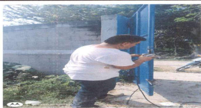
Foto 12: Cambio de chapa de porton
