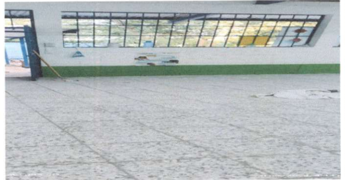
Foto 2: Sustitución de piso granito
