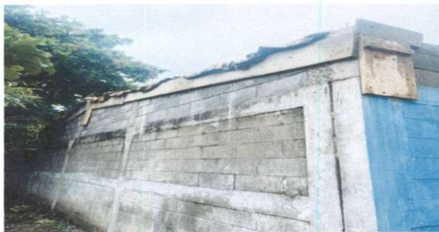
Foto 5: Reparacion de muro perimetral
