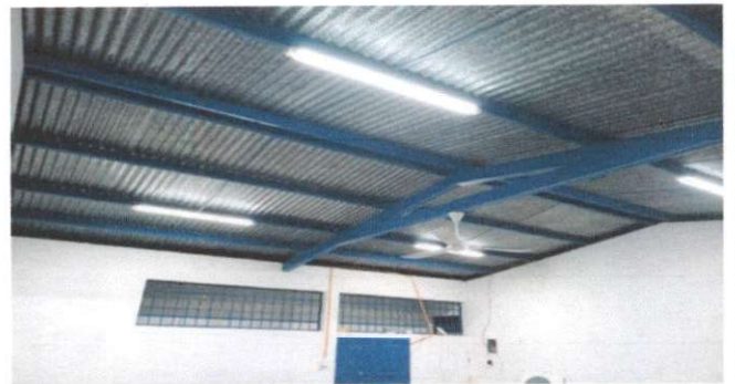
Foto 4: Intalacion de unidades de luz
