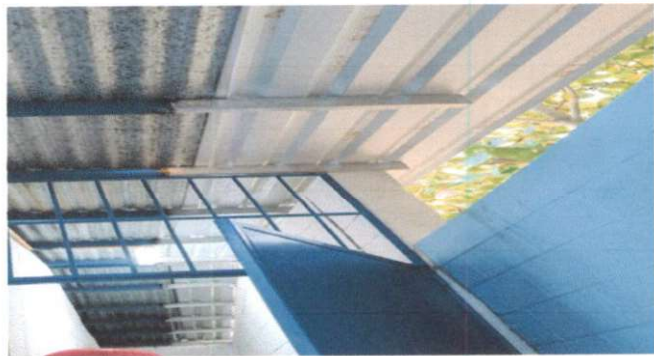
Foto 7. Sustitucion de estructura de soporte de metal por metal
