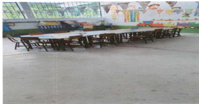
Foto 2: SUSTITUCION DE PISO GRANITO
