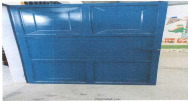
Foto 8: MANTENIMIENTO A ESTRUCTURAS
