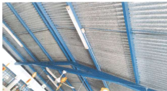
Foto 4: INSTALACION DE UNIDADES DE LUZ
