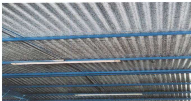
Foto 3: SUSTITUCION DE DUCTO + ACCESORIOS
