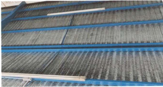
Foto 7: SUSTITUCION DE ESTRUCTURA DE SOPORTE METAL POR METAL
