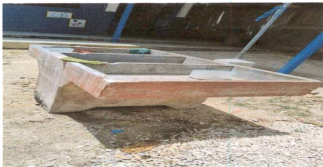
Foto 11: SUSTITUCION DE PILA DE DOS LAVADEROS
