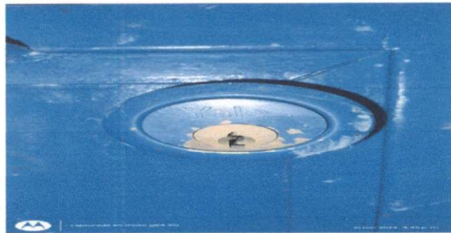
FOTO 12: CAMBIO DE CHAPA DE PORTON
