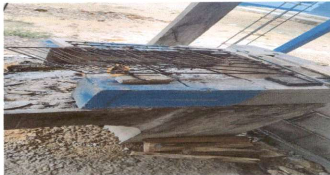
Foto 10: SUSTITUCION DE ESTUFA RURAL
