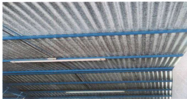
Foto 6: SUSTITUCION DE LAMINA POR LAMINA TROQUELADA ALUZINC CALIBRE 26
