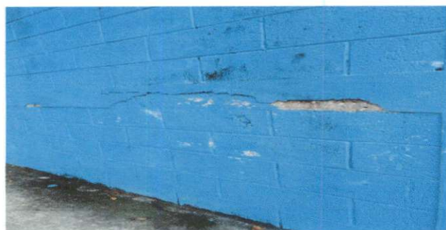
Foto 5: REPARACION DE MURO PERIMETRAL
