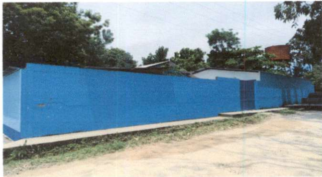
Foto 1: PINTURA DE MUROS INTERIORES Y EXTERIORES
