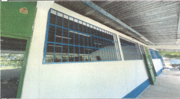
PINTURA EN MUROS EXTERIORES UE INTERIORES
