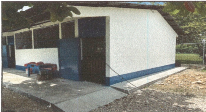
FOTO 3: MANTENIMIENTO DE PUERTA DE METAL
