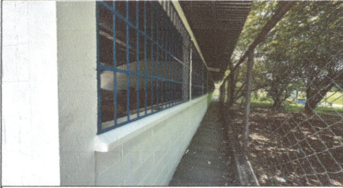
Foto1: SUSTITUCION DE BALCONES DE METAL
