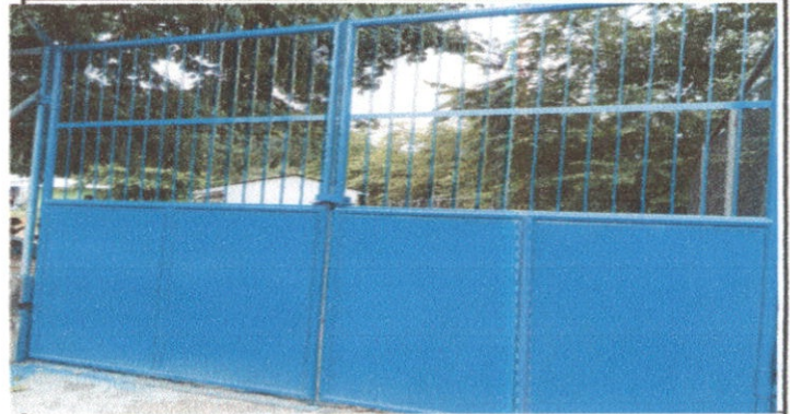
Foto 2: SUSTITUCION DE PORTON DE METAL
