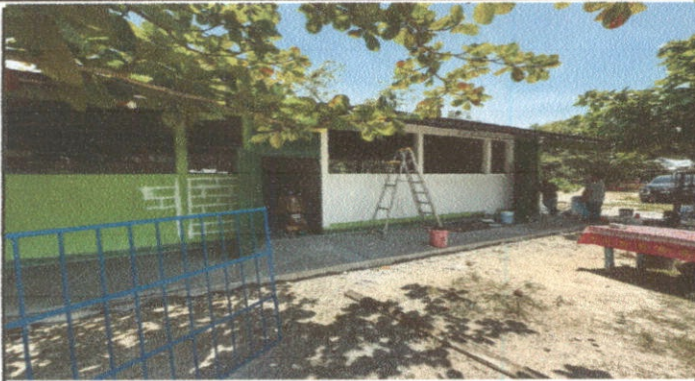
Foto 1: PINTURA EN MUROS INTERIORES E EXTERIORES
