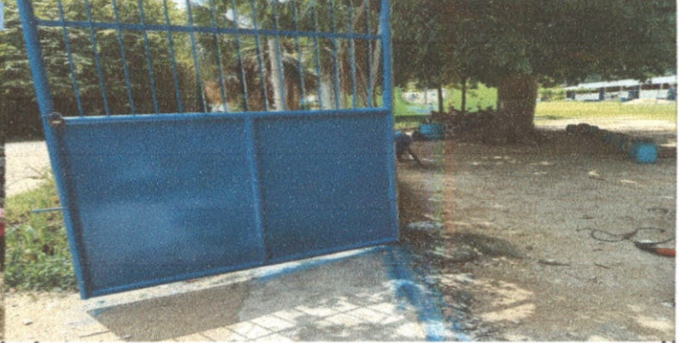
Foto 2: SUSTITUCION DE PORTON DE METAL
