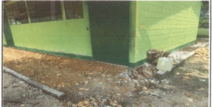
SUSTITUCION DE TORTA DE CONCRETO
