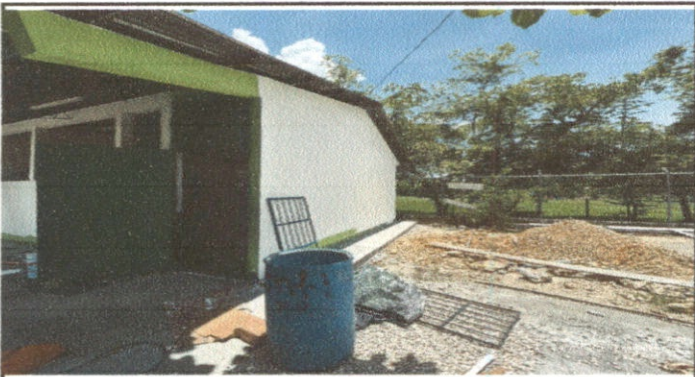
FOTO 3: MANTENIMIENTO DE PUERTAS DE METAL DE METAL
