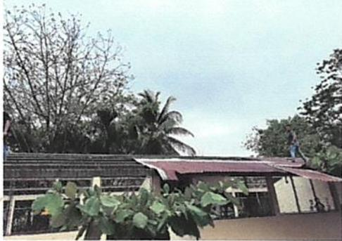
Foto 1: Sustrucción de lamina, por lamina troquelada aluzink calibre26.
