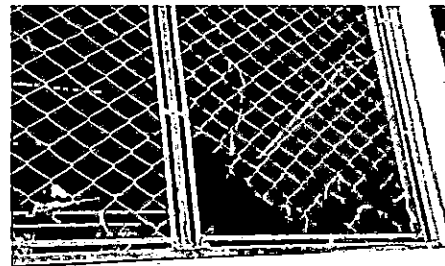
Foto 4: Sustitución de estructura de metal de ventana.
