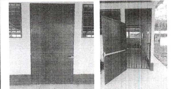
Foto 3: Puertas de Metal (Mantenimiento a estructura (lijado, cambio de tubo, cepillado, sujeciones, aplicación de pintura)
