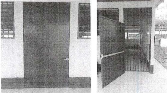
Foto 3: Puertas de Metal (Mantenimiento a estructura (lijado, cambio de tubo, cepillado, sujeciones, aplicación de pintura)
