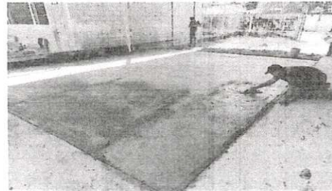
Foto 4: Reparación de piso de torta de concreto
