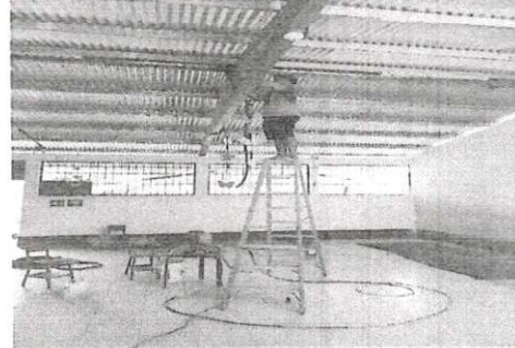
Foto 8: Reparación de Sistema Eléctrico
