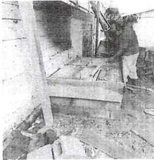
Foto 9: Sustitución de estufa rural
