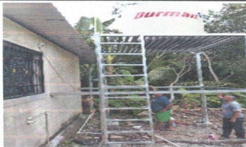
Foto 9: SUSTITUCIÓN DE DEPÓSITO PARA AGUA.
