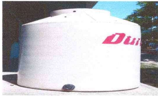
Foto 9: SUSTITUCIÓN DE DEPÓSITO PARA AGUA.
