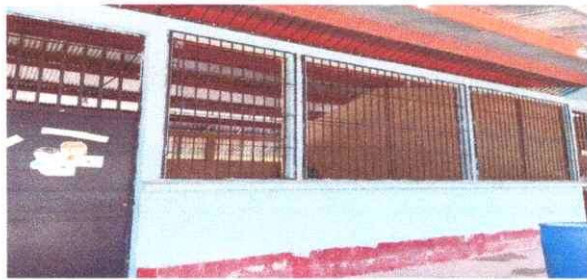
Foto 11: MANTENIMIENTO A BALCONES DE METAL.
