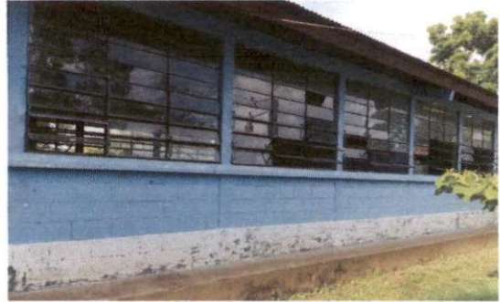
Foto 2: Sustitución de balcones de metal
