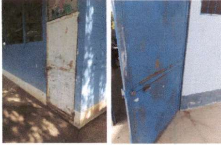
Foto1: Sustitución de puertas
