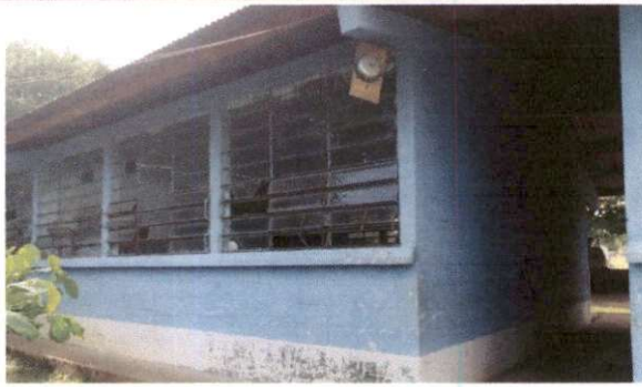
Foto 3: Pintura en muros exteriores e interiores
