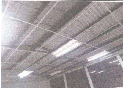
Foto 1: Sustitución de estructura de soporte de metal, por metal
