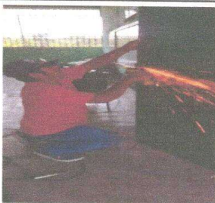
Foto 3: Sustitución de puerta.
