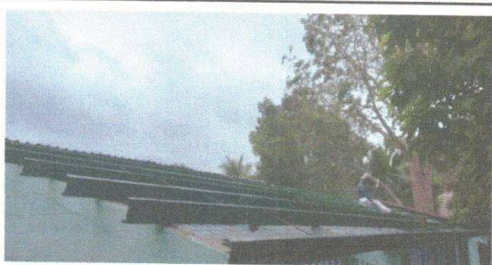
Foto 1: Sustitución de estructura de soporte de metal, por metal
