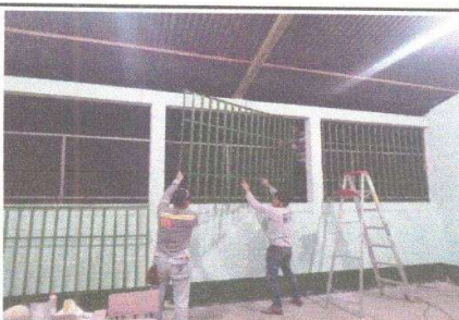
Foto 4: Sustitución de ventanas de madera por metal mas vidrio
