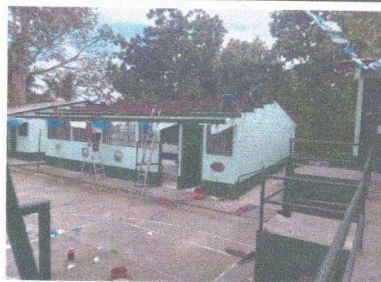
Foto 2: Sustitución de lámina, por lámina troquelada aluzinc calibre 26
