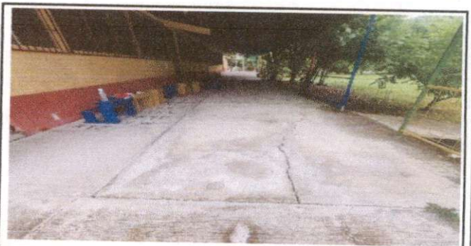
FOTO 6 Reparacion de plancha de concreto de patio.
