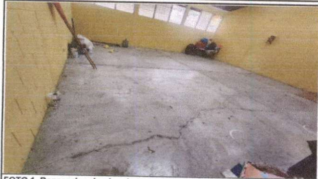
FOTO 1. Reparacion de piso de torta de concreto.
