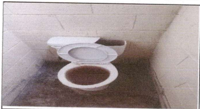
FOTO 4. Sustitucion de inodoro.
