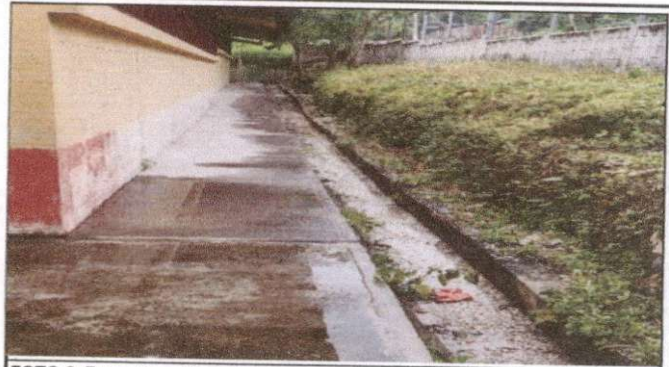
FOTO 2. Reparacion de cuneta de concreto.
