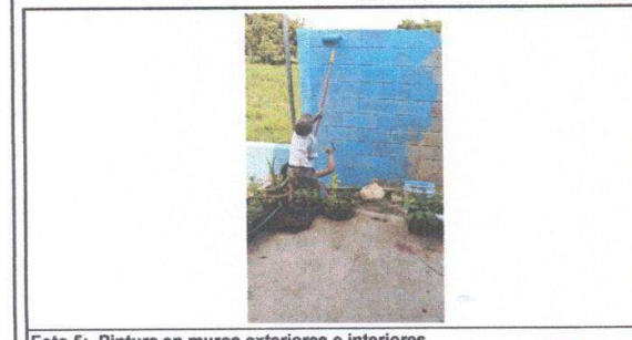
Foto 5: Pintura en muros exteriores e interiores
