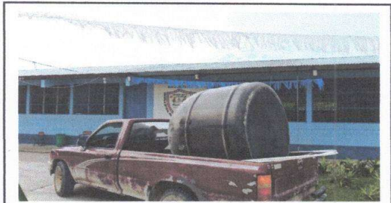
Foto 3: Sustitución de deposito de agua 1700 lt
