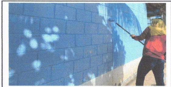
Foto 6: Pintura en muros exteriores e interiores
