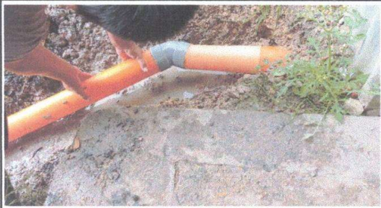
Foto 7: Sustitución de tubería PVC línea principal aguas negras.
