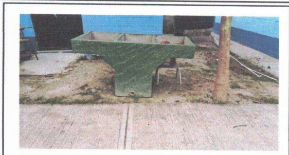
Foto 2: Sustitución de pila de cemento de dos lavadero / Reparación de Cocina
