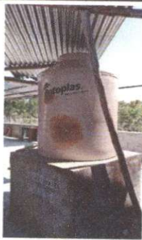
Foto 3: Sustitución de deposito de agua 1700 lt
