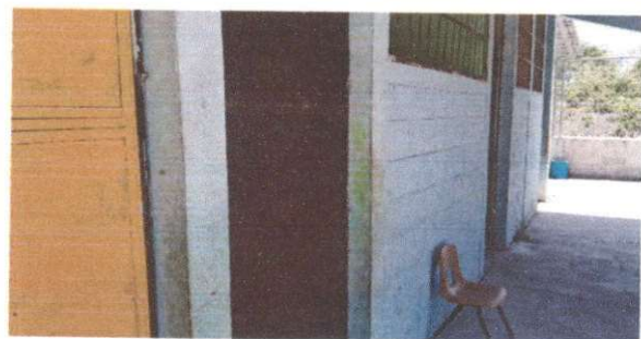
Foto 6: Pintura en muros exteriores e interiores
