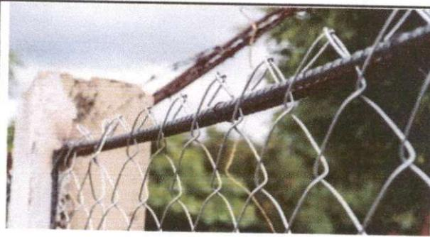
Foto 4: Muro perimetral / Reparación de tubo y malla galvanizada
