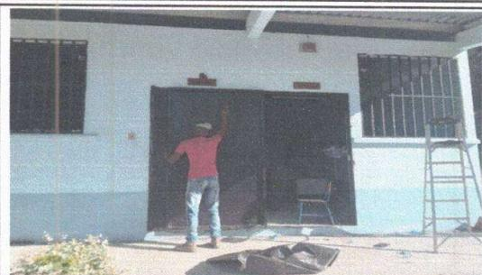
FOTO 2: Mantenimiento a estructura (lijado, cambio de tubo, cepillado, aplicación de pintura)
