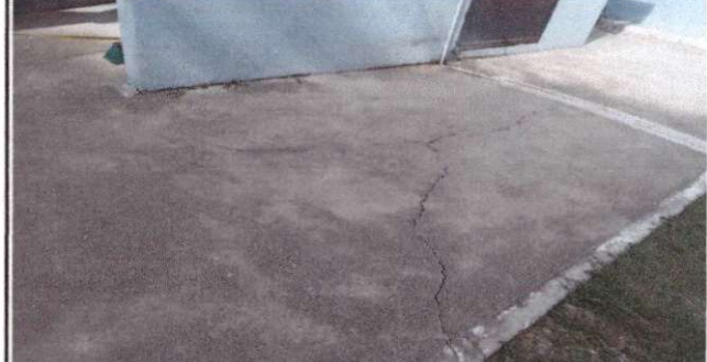
FOTO 4: Sustrucción de piso de torta de concreto
