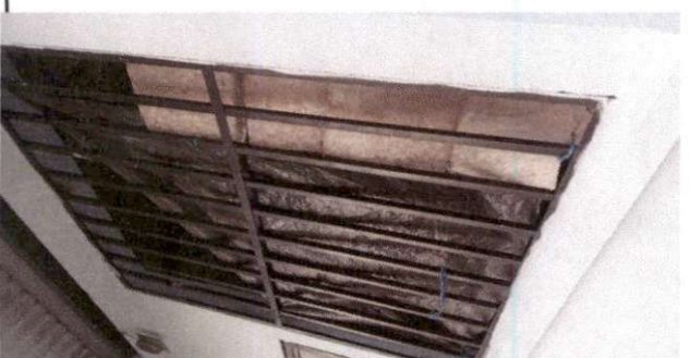
FOTO 3: Mantenimiento de balcones de metal
