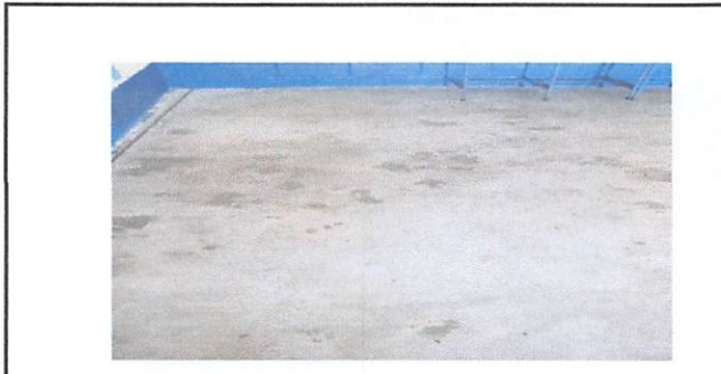
Foto 5: instalación de piso cerámico.
