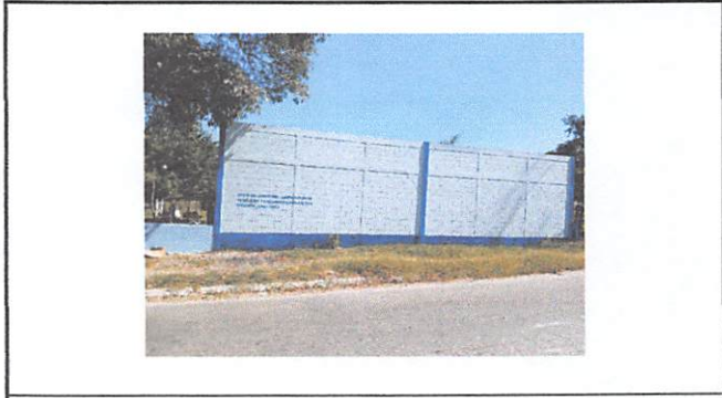
Foto 8: Pintura en muros exteriores e interiores
