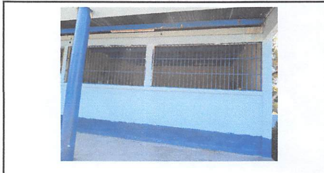
Foto 4: mantenimiento a balcones y puertas de metal
