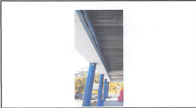
Foto7: sustitución de soporte de metal por metal
