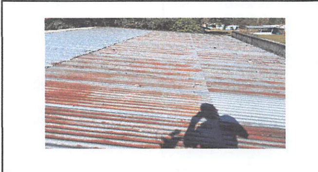
Foto1: cambio de lámina por lámina de aluzinc
