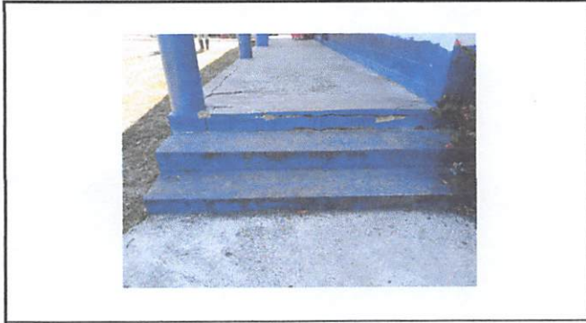
Foto 9: Reparación de Banqueta de concreto
