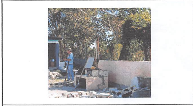
Foto 10: Instalación base para Rotoplas.
