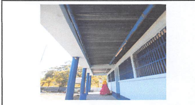
Foto 2: mantenimiento a estructura de soporte de metal
