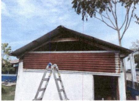
Foto 1: Sustitucion de lamina, por lamina troquelada aluzink calibre 26
