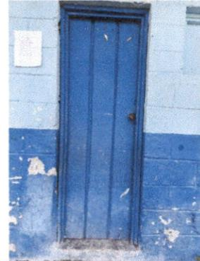
Foto 4: Sustitucion de puertas de madera por metal para aulas con chapa yale
