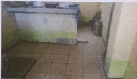
Foto 5: sustitución de piso ceramico
