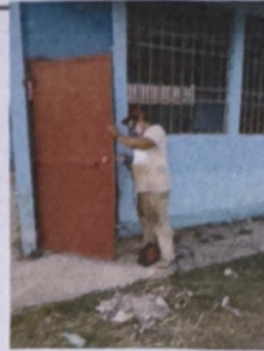
Foto 4: mantemiento a estructura de puertas
