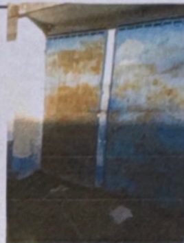
Foto 4: mantemiento a estructura de puertas
