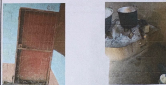
Foto 6: sustitucion de puertas, sustitucion de estufa rural
