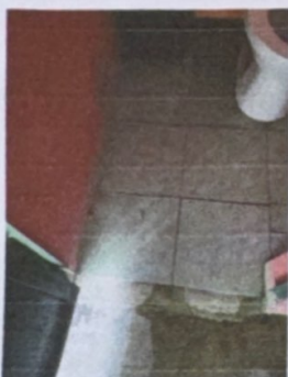
Foto 5: sustitución de piso ceramico
