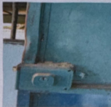
Foto 2: sustitucion de chapas
