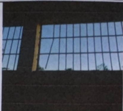
Foto 1: mantenimiento a balcones
