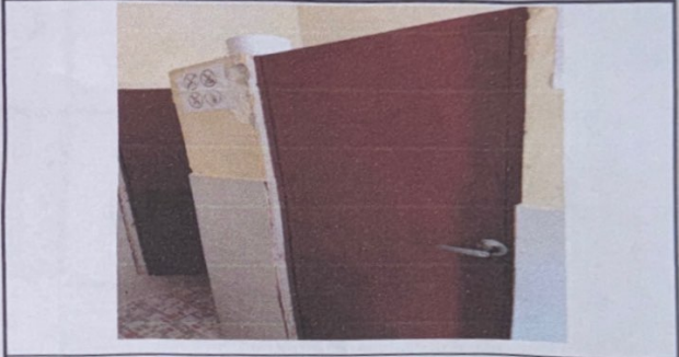
Foto 4: S Sustitucion de puertas en servicios sanitarios
