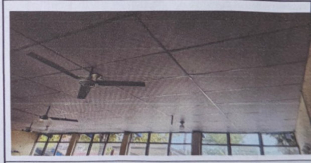
Foto 6: Instalacion de planchas de cielo falso
