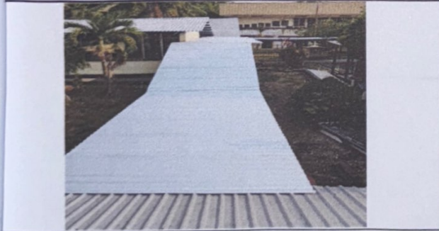
Foto 5: Sustitucion de lamina por lamina troquelada de aluzinc calibre 26
