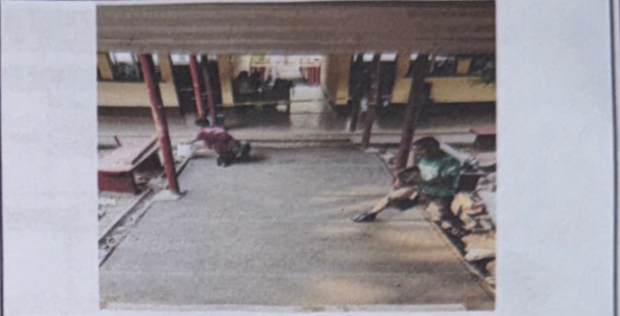
Foto 2: Reparacion de Planchs de Concreto
