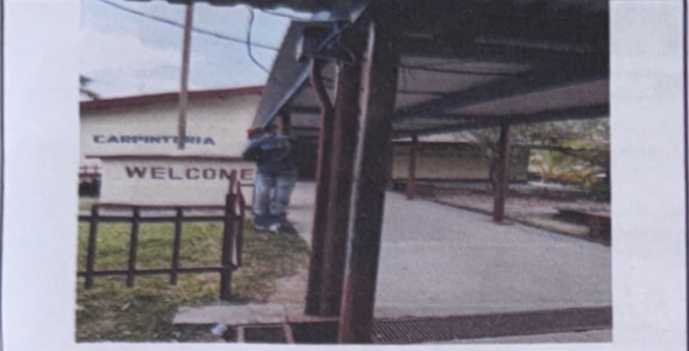
Foto 1: Mantenimiento de estructura portante.
