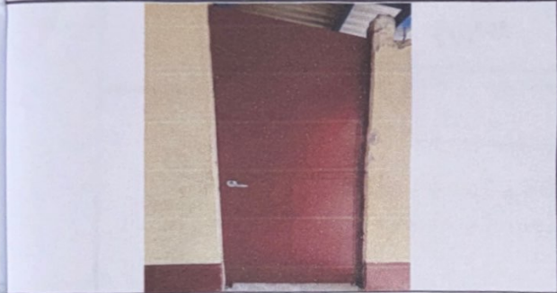
Foto 3: Sustitucion de puertas en servicios sanitarios
