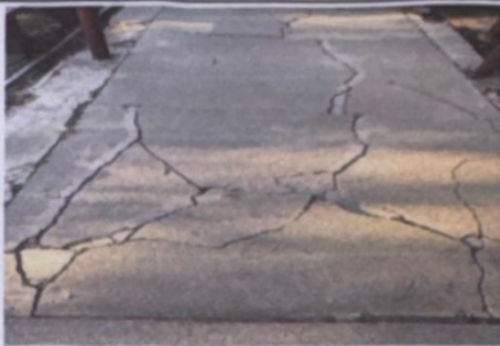
Foto 3: Reparación de planchas de concreto de patio.
