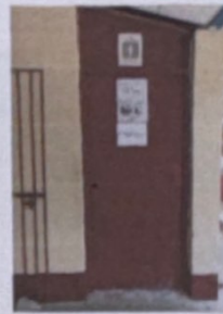
Foto 4: Sustitución de puerta en servicios sanitarios.
