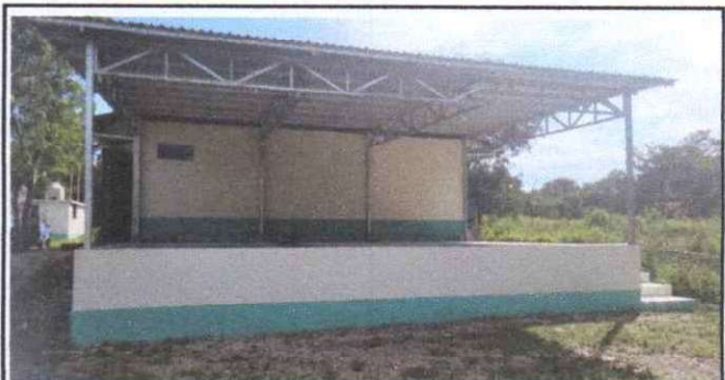
Foto 6: Pintura en muros exteriores e interiores
