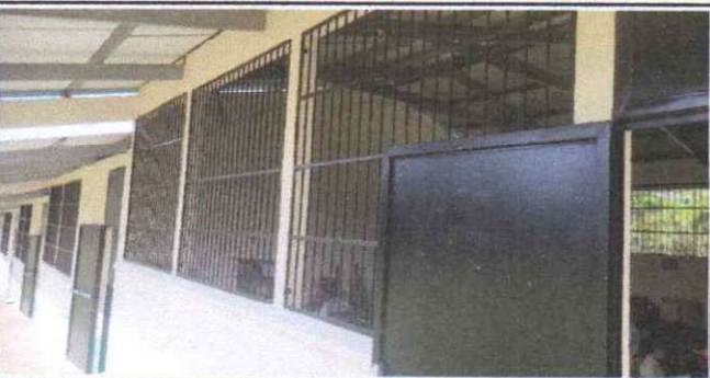
Foto 5: Mantenimiento a balcones de metal
