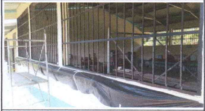
Foto 4: Mantenimiento a estructura (lijado, cambio de tubo , cepillado, sujeciones, aplicación de pintura)
