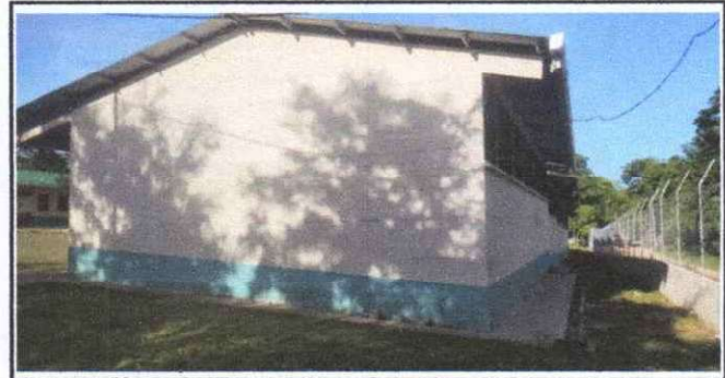
Foto 6: Pintura en muros exteriores e interiores
