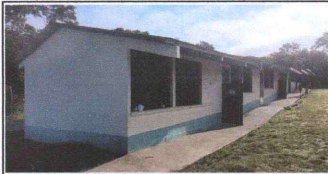
Foto 5: Mantenimiento a balcones de metal
