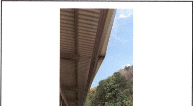
Foto 4: Sustitucion de canal de metal antes
