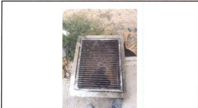
Foto 1: Mantenimiento cajast registro antes
