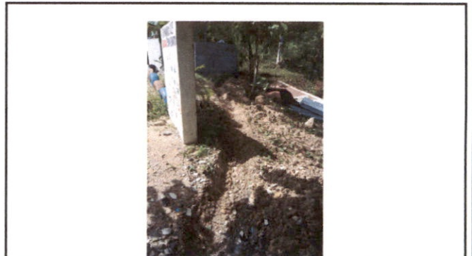
Foto 4: Instalación de tubería PVC antes
