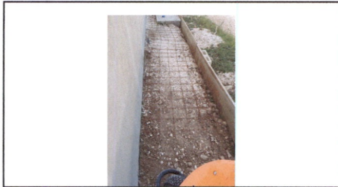
Foto 1: Reparación de banqueta de concreto
