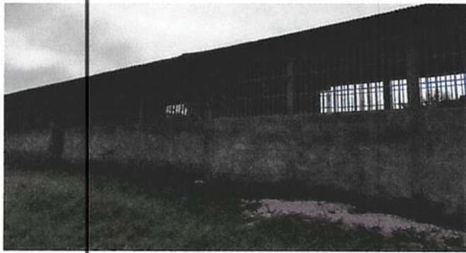
SUSTITUCIÓN DE BALCON DE METAL
