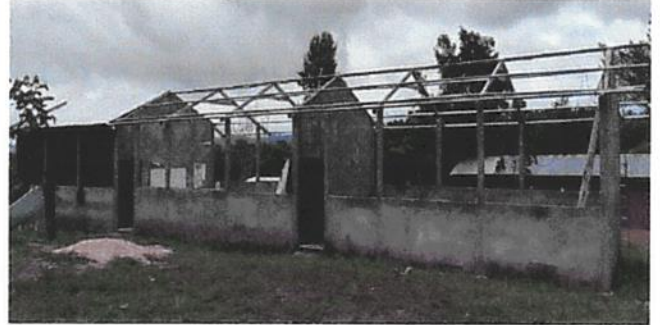
SUSTITUCIÓN DE SOPORTE DE MADERA, POR METAL
