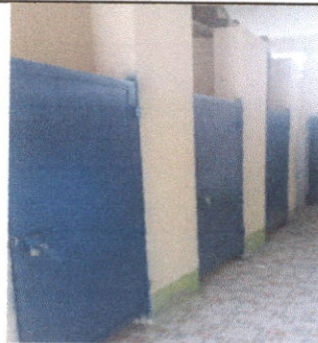
Foto 6: Avance de pintura puertas de los baños
