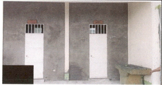
Foto 4: Reparación de pared agrietada
