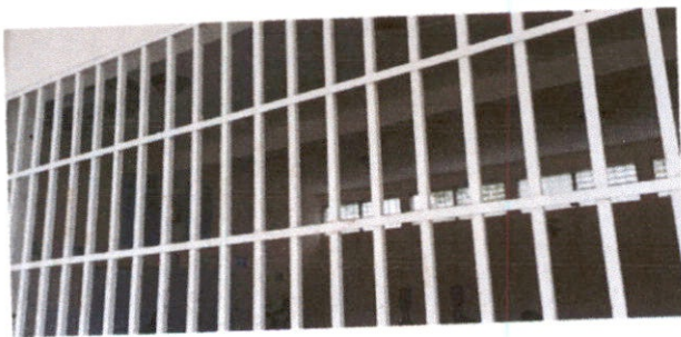
Foto 5: Trabajos de alijado de balcones
