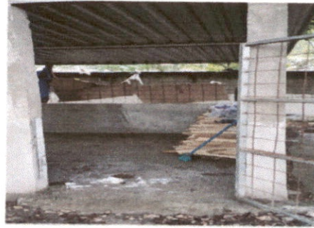
Foto 4: Trabajos en la cocina
