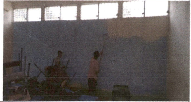
Foto 2: Pintando el interior de las aulas
