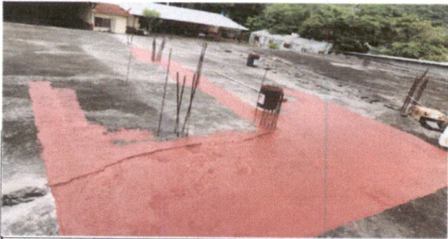
Foto 5: Trabajos de impermeabilización de losa
