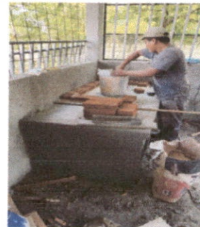
Foto 6: Elaboración del poyeton en la cocina
