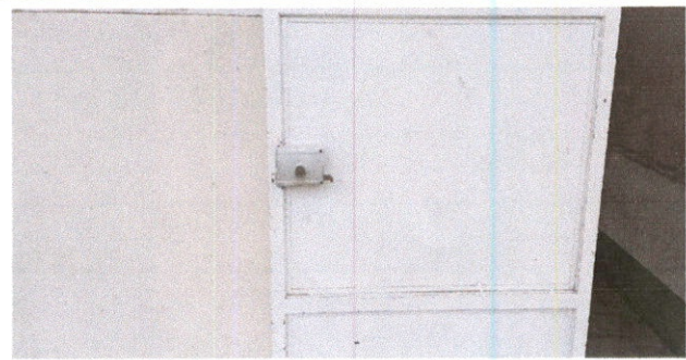
Foto 3: Reparación de cuatro chapas
