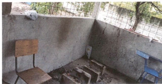
Foto 4: Pintura del área de cocina
