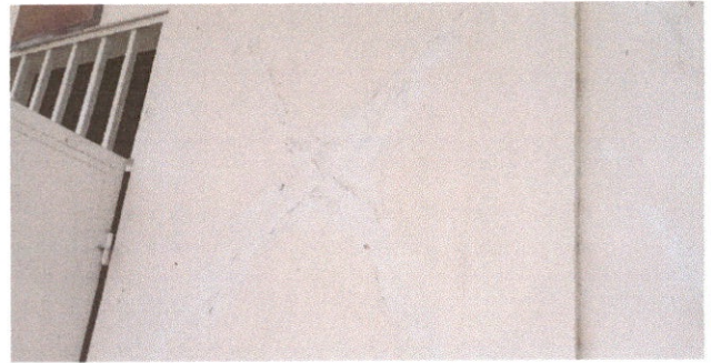
Foto 2: Repello en áreas dañadas
