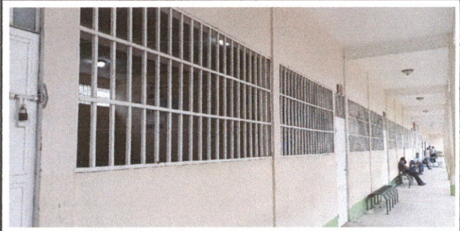
Foto 6: Pintura de balcones
