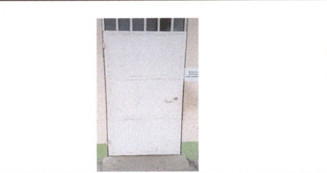
Foto 6: Pintura de puertas
