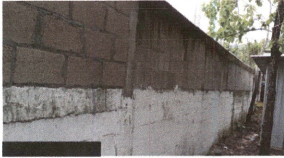
Foto 1: Repello interno y externo
