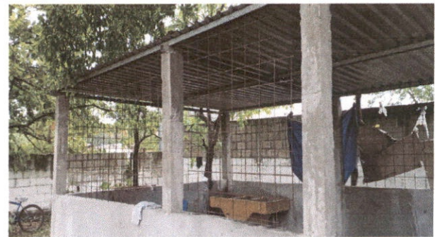
Foto 4: Colocación de balcones, área de cocina
