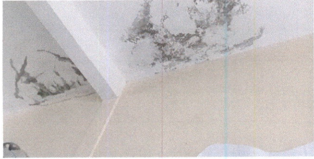
Foto1: Arreglo en el techo
