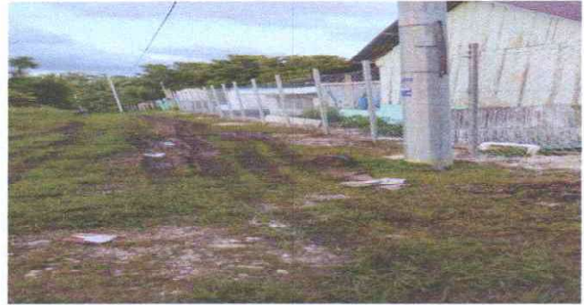
REPARACIÓN DE TUBO HG MAS MALLA GALVANIZADA
