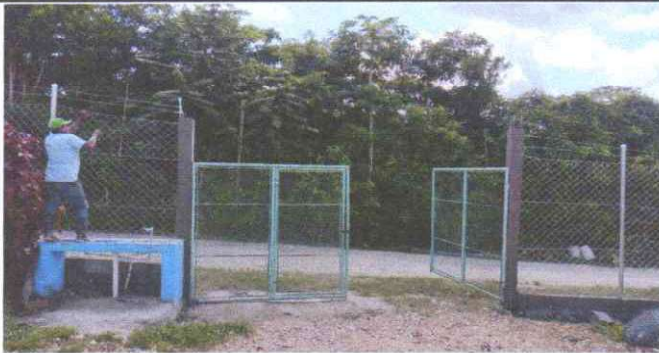
MANTENIMIENTO A PORTON
