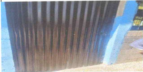
SUSTITUCIÓN DE PUERTAS
