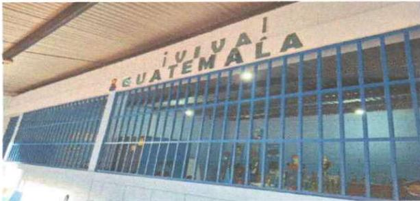
Foto 17: SUSTITUCIÓN A ESTRUCTURA DE METAL EN VENTANA
