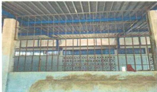
Foto 19: SUSTITUCIÓN A ESTRUCTURA DE METAL EN VENTANA
