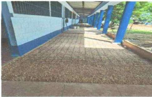
Foto 15: SUSTITUCIÓN DE PISO TORTA DE CONCRETO
