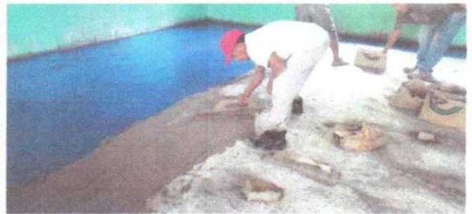
Foto 2: Llenado de cemento con pintura de piso líquido para la reparación en aula 2
