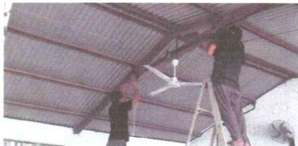
Foto 3: sustitución de ducto electrico mas accesorios, sustitución de cableado electrico, sustitución de plafoneras en todo el establecimiento educativo
