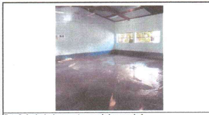
Foto 5: Acabado de cemento para el piso en aula 1
