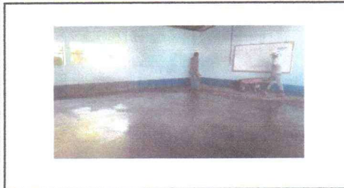
Foto 3: Continuacion de la reparación de piso con cemento liquido en aula 1
