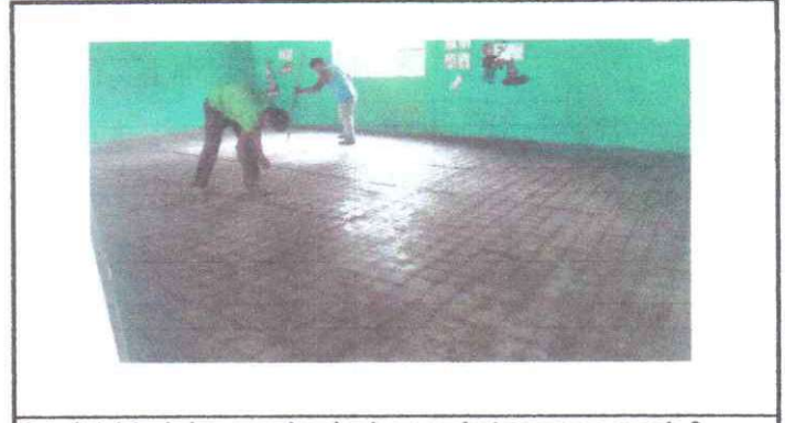
Foto 2: Inicio de la reparacion de piso con electromaya en en aula 2
