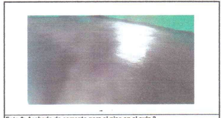
Foto 6: Acabado de cemento para el piso en el aula 2
