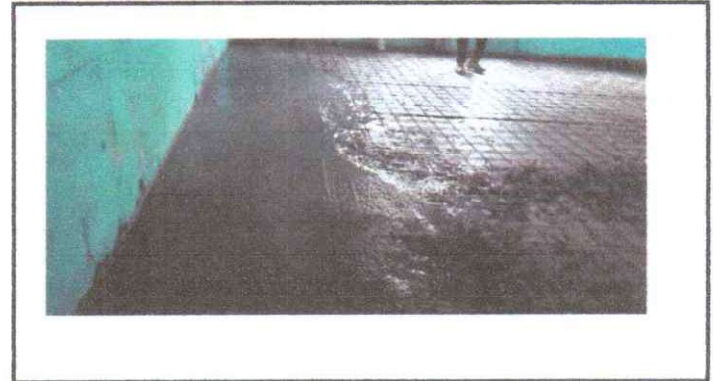
Foto 4: Continuación de la reparación de piso con cemento liquido en aula 2
