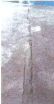
foto 3: piso líquido en mal estado, previo a su reparación
