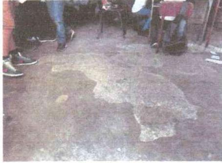
foto 1: Estado previo a la reparación del piso líquido en dos aulas
