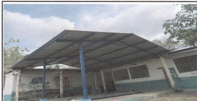
Foto 6: SUSTITUCIÓN DE ESTRUCTURA DE TECHO DE MADERA POR METAL Y METAL POR METAL
