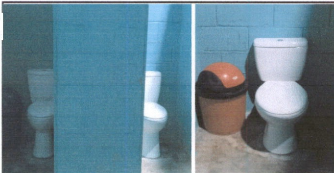
Foto 5: SERVICIOS SANITARIOS Y SUS ACCESORIOS
