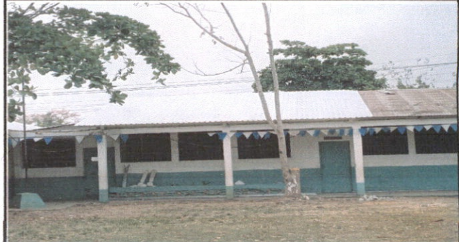
Foto 2: SUSTITUCIÓN DE LÁMINA POR LÁMINA TROQUELADA ALUZINC CALIBRE 26 m2 344MTS
