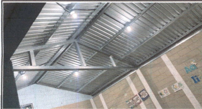
Foto 3: REPARACIÓN Y SUSTITUCIÓN DE LA ENERGIA ELECTRICA
