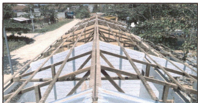
Foto 4: SUSTITUCIÓN DE ESTRUCTURA DE TECHO DE MADERA POR METAL Y METAL POR METAL
