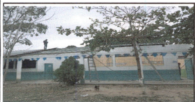
Foto 3: REPARACIÓN Y SUSTITUCIÓN DE LA ENERGÍA ELECTRICA
