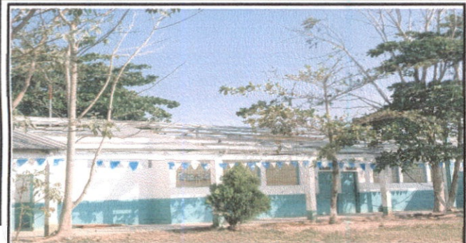
Foto1: SUSTITUCIÓN DE LÁMINA POR LÁMINA TROQUELADA ALUZINC CALIBRE 26 m2 344MTS
