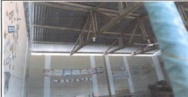
Foto 3: SUSTITUCION DE ESTRUCTURA DE SOPORDE DE MADERA POR METAL
