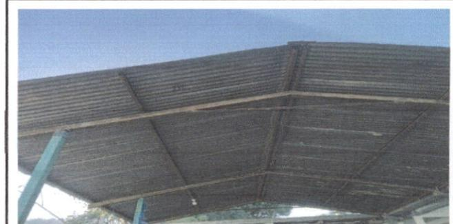
Foto 6: SUSTITUCIÓN DE ESTRUCTURA DE SOPORTE DE METAL POR METAL. SUSTUTUCIÓN DE LÁMINA, POR LÁMINA TROQUELADA CALIBRE 26
