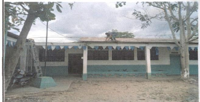
Foto 2: LINEA 2 SUSTITUCIÓN DE LÁMINA, POR LÁMINA TROQUELADA ALUZINC, CALIBRE 26.
