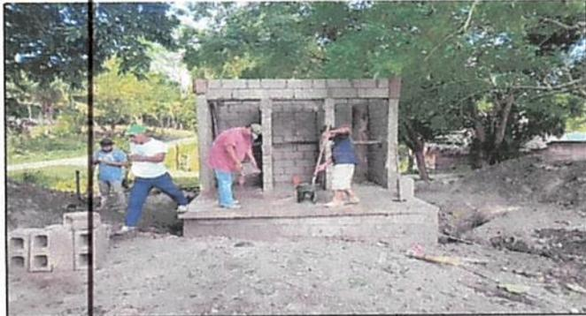
Foto 1: ASÍ ES COMO SE ESTA REALIZANDO EL LEVANTAMIENTO DE DE LAS PAREDES Y COLOCANDO LA BASE DELANTERA DEL BAÑO PARA DEJARLO FIRME Y COLOCARLE LAS TAZAS.
