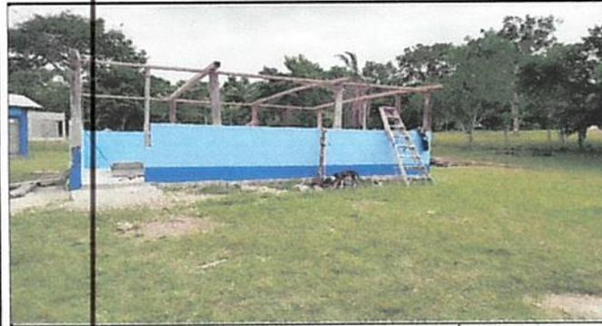
Foto 3: ASÍ ES COMO SE LE ESTABA QUITANDO LAS LÁMINAS DE LA COCINA Y LAS ESTRUCTURAS DE MADERA PARA CAMBIARLOS POR METAL.
