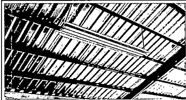
Foto 5: Sustitución de lamparas tipo LED
